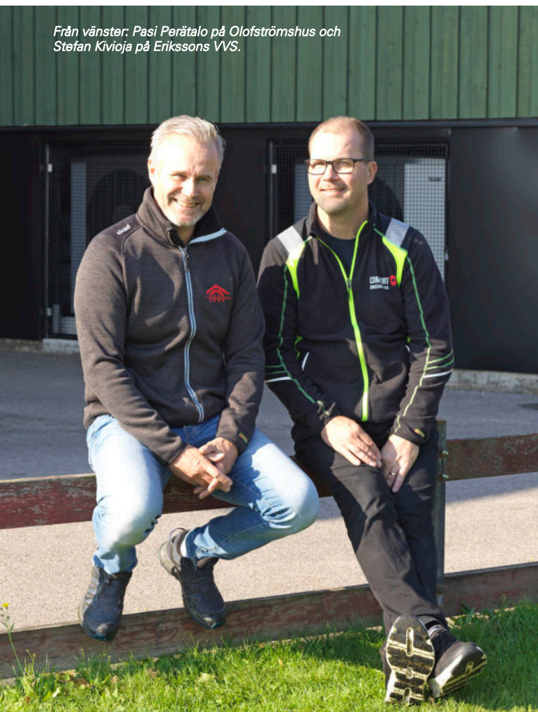
För att man ska kunna komma åt och serva maskinerna och för att värmepumparna ska få ordentligt med luft tog man upp ett stort hål i fasaden vid sidan och satte galler som dörrar framför värmepumparna.
