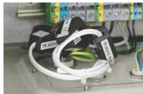
Bipackade strömkännare sätts på inkommande fasledare och mäter mängden ström.
